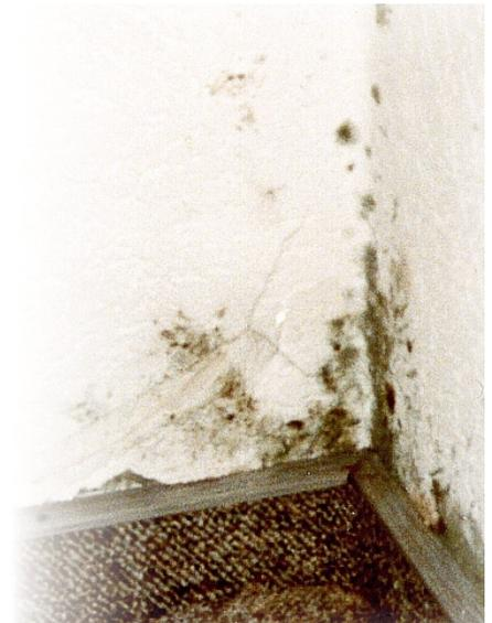
Wegen der geringeren Dichte von tragenden Böden und Decken entstehen besonders dort Wärmebrücken. Bei fehlender Belüftung bildet sich zuerst Feuchtigkeit und dann Schimmel.
